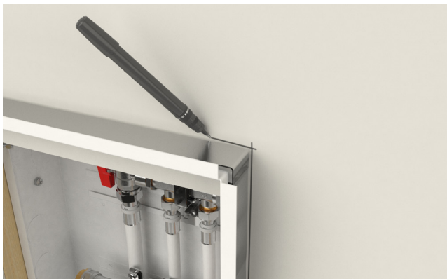
Markera ramens utsida på gipsskivan.
